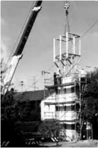
Bau des neuen Glockenturmes, 1986
